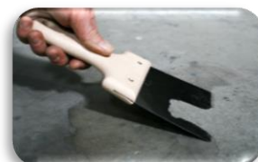
Raclage au couteau ou spatule autour des zones dégrainées.
